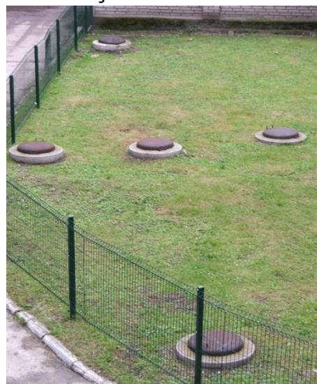
Rys. 12. Laboratorium Geoenergetyki Wydziału Wiertnictwa, Nafty i Gazu AGH, pompy ciepła (a), studzienki nad otworowymi wymiennikami ciepła (b)
